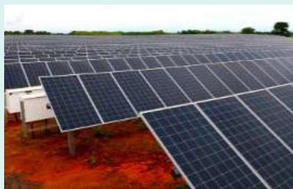
Le projet de construction de la centrale solaire photovoltaïque à Dapaong, entre dans le cadre du projet régional d'intervention d'urgence en Energie solaire (RESPITE). Situé à Dapaong dans la région des savanes, il est d'une capacité de 25 MWh avec 40 Mégawatts-heures de stockage batteries et va desservir 12 100 ménages.
