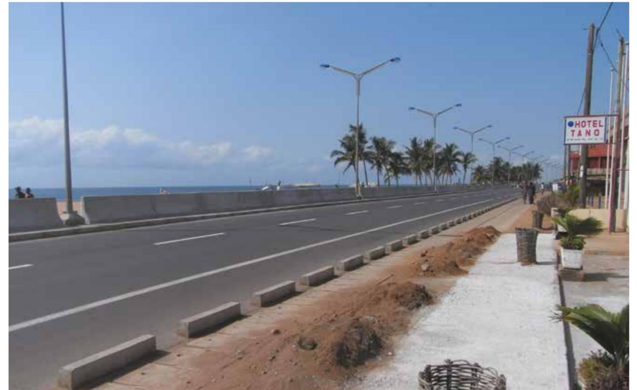
une partie importante du corridor côtier Abidjan-Lagos et ce, dans un partenariat public-privé. A terme, la largeur de la voie passera de 10 à 24 mètres. Près de 96,543 milliards sont déboursés pour la réalisation de l'ouvrage qui inclut le drainage des eaux, l'éclairage, la signalisation et la protection des côtes togolaises.
